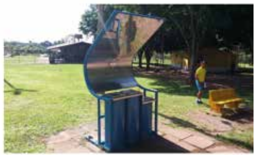
Reforma de bebedouros
