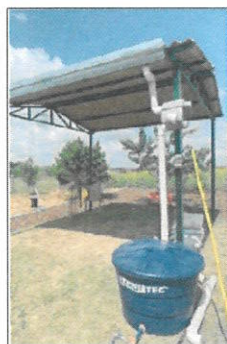
Figura 40. Sistema de captação de água da chuva no Circuito Saneamento Rural e SAN da AgroBrasília
