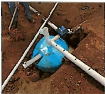
Foto 18. Instalação de sistema individual de esgotamento sanitário
