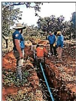
Foto 19. Instalação de rede enterrada
