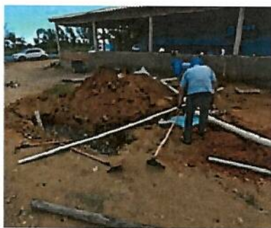
Foto 17. Instalação de sistema individual de esgotamento sanitário
