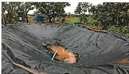
Foto 21. Implantação de geomembrana - tanque individual (54m³)
