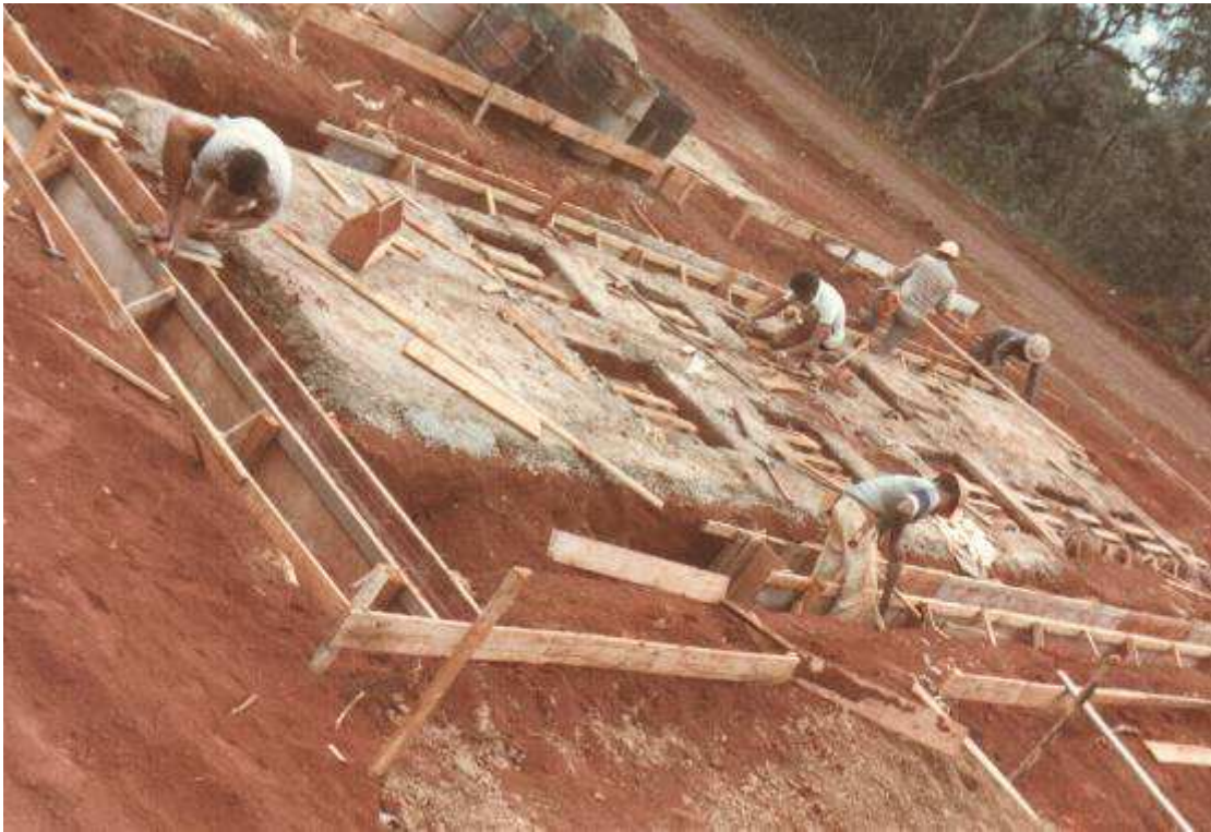
Figura 19 - Construção dos alicerces do Portão Principal do Jardim Botânico de Brasília, (fotografia de Georges Lodygenski).
