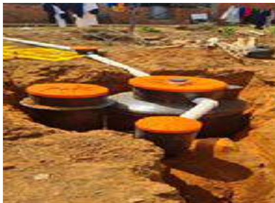
Figura 42 - Sistema de esgotamento sanitário individual
