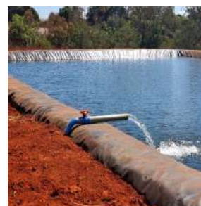
Revestimento de reservatórios. A instalação de geomembranas PEAD em reservatórios de água para irrigação busca eliminar perdas por infiltração e otimizar o uso da água nas propriedades. Por acordo de cooperação com o Comitê de Bacias Hidrográficas do São Francisco, foram adquiridos 247 kits de revestimento para reservatórios de 430 m³. Até novembro de 2025, foram escavados e instalados 50 kits , permitindo armazenamento de mais de 20,7 milhões de litros de água para irrigação e criação de peixes (Figuras 84, 85, 86 e 87).
