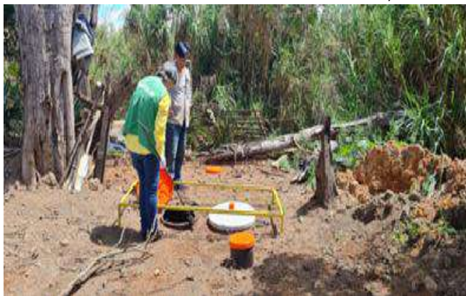
Figura 41 - Instalação de sistema de esgotamento sanitário
